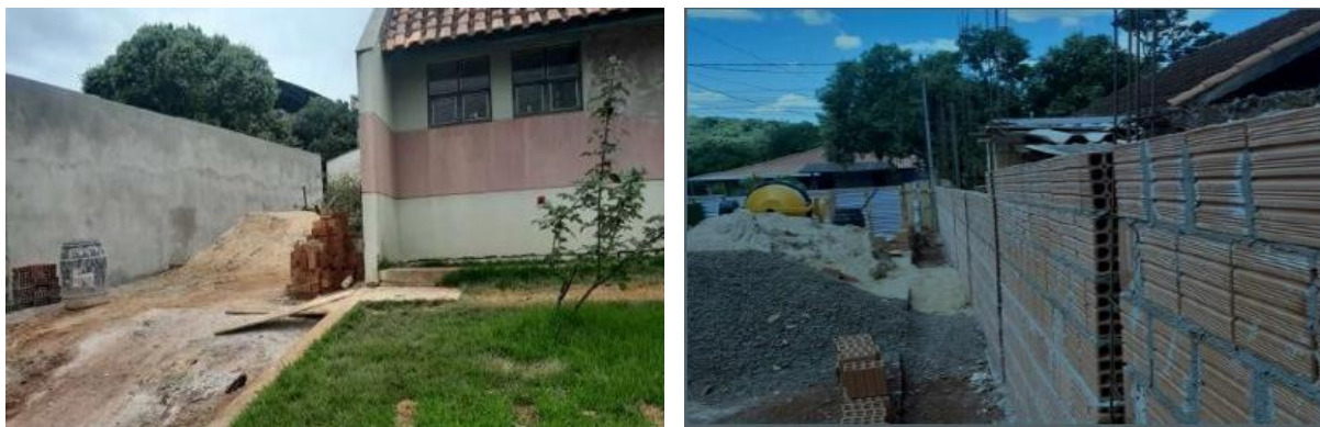
Ampliação e Reforma da UBS Irerê
