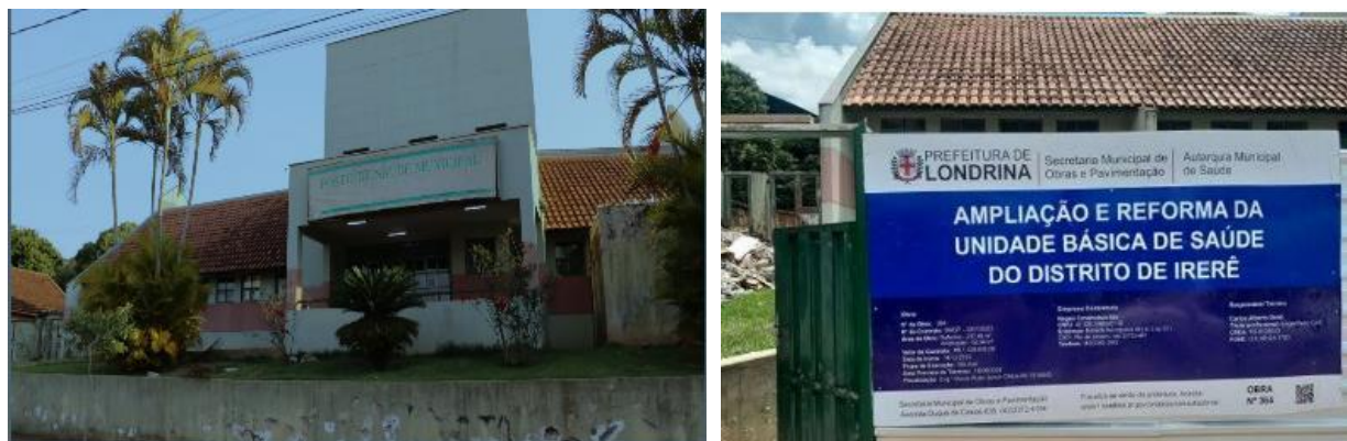
Ampliação e Reforma da UBS Irerê
