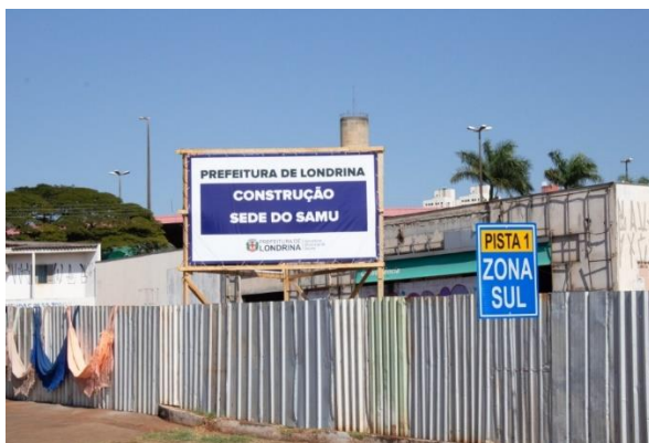
Construção da Sede do SAMU Regional Norte Londrina Início das obras em 27/07/2020
