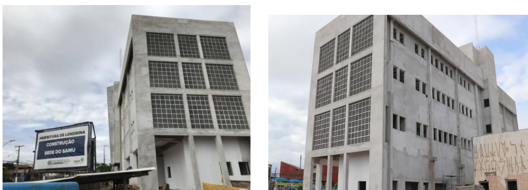
Construção da Sede do SAMU Regional Norte Londrina; andamento da obra
